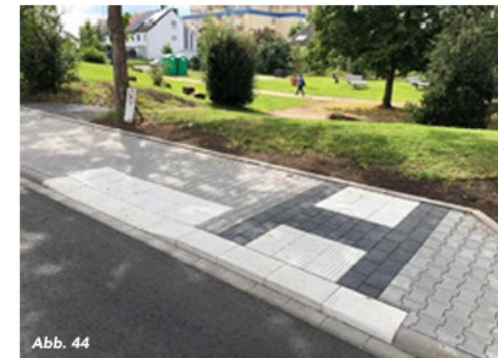
Abb. 43 und 44: Querungsstellen mit differenzierter Bordhöhe in Fulda (gesichert mit Lichtsignalanlage) und Nauheim (ungesichert)
