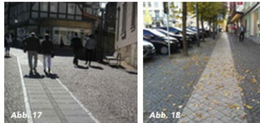
Abb. 17: Bad Wildungen. Die Gehbahn ist durch einen schmalen Begleittreifen visuell etwas hervorgehoben Abb. 18: Die gut berollbare Gehbahn in Warburg unterscheidet sich taktil und visuell deutlich vom Umgebungsbelag
