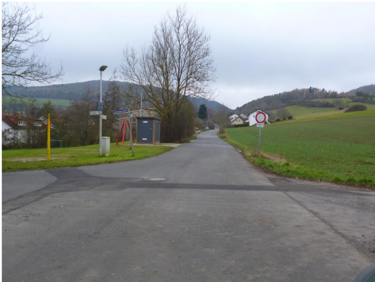
Der „Burgweg“ vor dem Umbau
