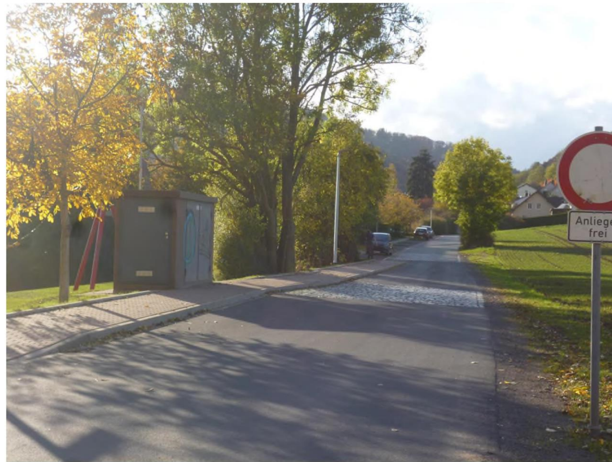
Nach dem Bau des Gehwegs
