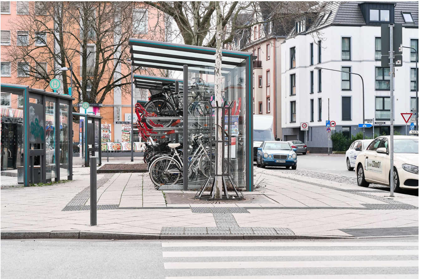
Abb. 11: Mit taktilen Bodenindikatoren gekennzeichnete Doppelstockanlage.
