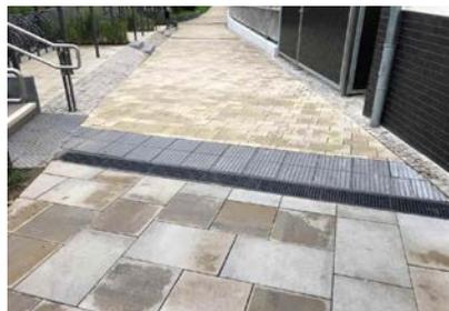
**Abb. 36:** Auffindestreifen für seitliche Treppen in Raunheim. Die Fahrradständer sind durch die Anrampung mit dem Langstock tastbar von der Gehbahn getrennt.
