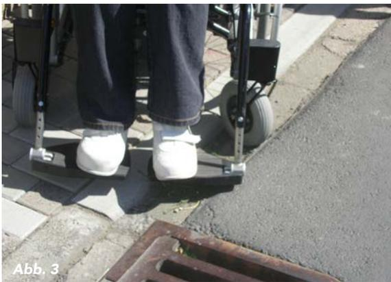
**Abb. 3:** An Engstellen müssen Borde oft überschritten werden, um die Fahrbahn mit zu benutzen. Zudem müssen sie dann oft noch schräg gequert werden. Deshalb ist eine weiche Separation (siehe Kap. 2.6 und RAS 5.2.5) in solchen Fällen die bessere Lösung.
