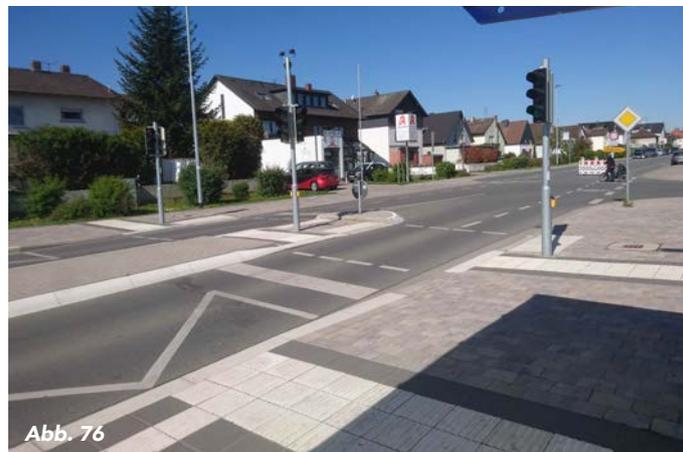
**Abb. 69 und 72:** Überquerungsstelle mit Mittelinsel und Lichtsignalanlage in Fulda
