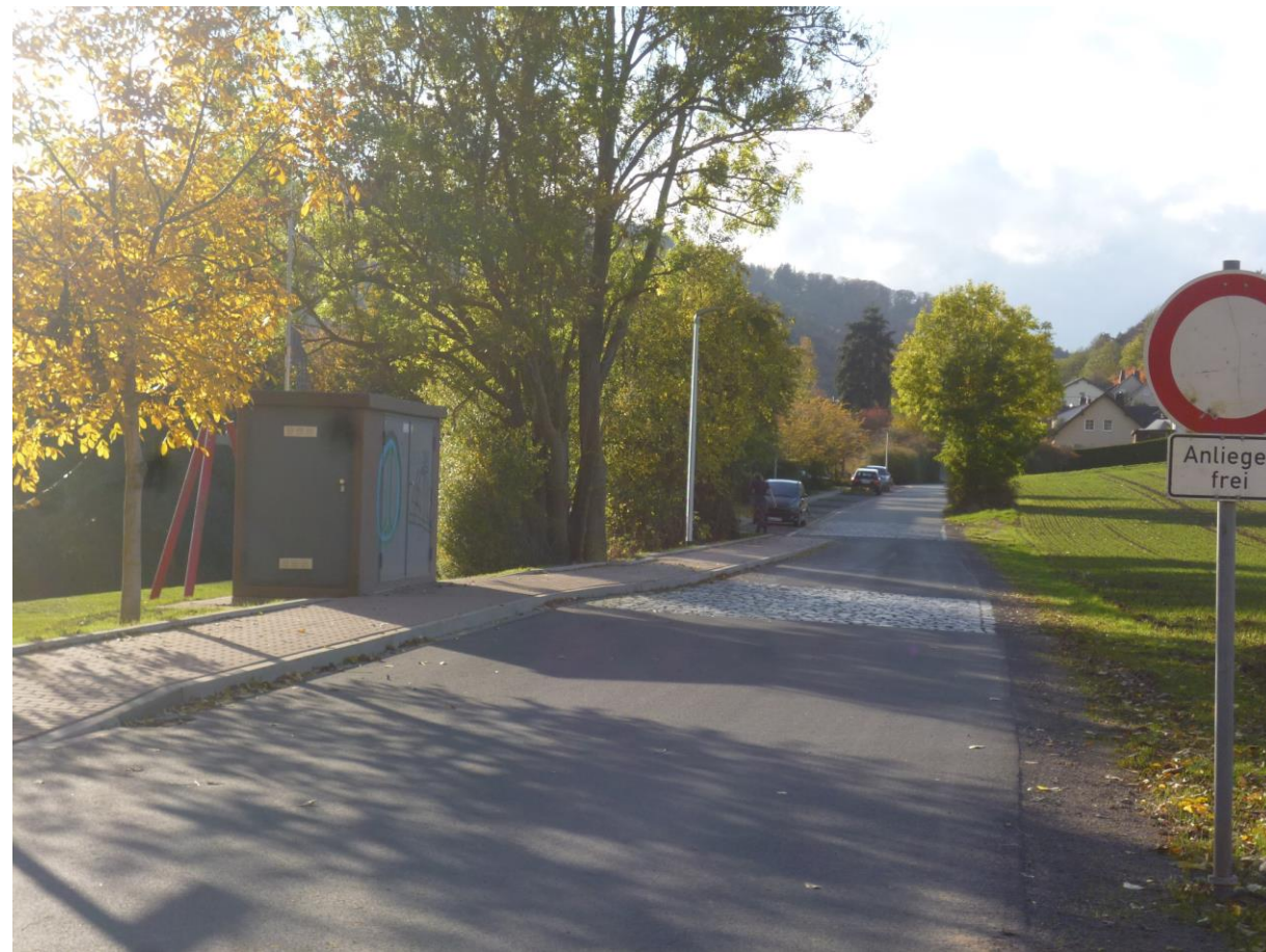
Nach dem Bau des Gehwegs
