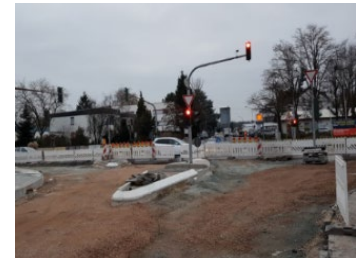
Bau-/Erhaltungs- und Sanierungsmaßnahme
