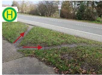
Fehlende Netzschlüsse
