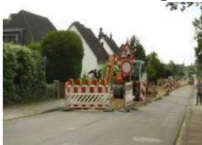
Leitungs- und Kanalsanierung
